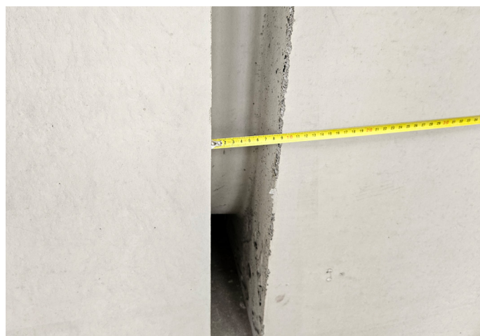
Obr. 5 Doporučená vnější spára rámových propustí před zahájením spojování řetězovým stahovákem
