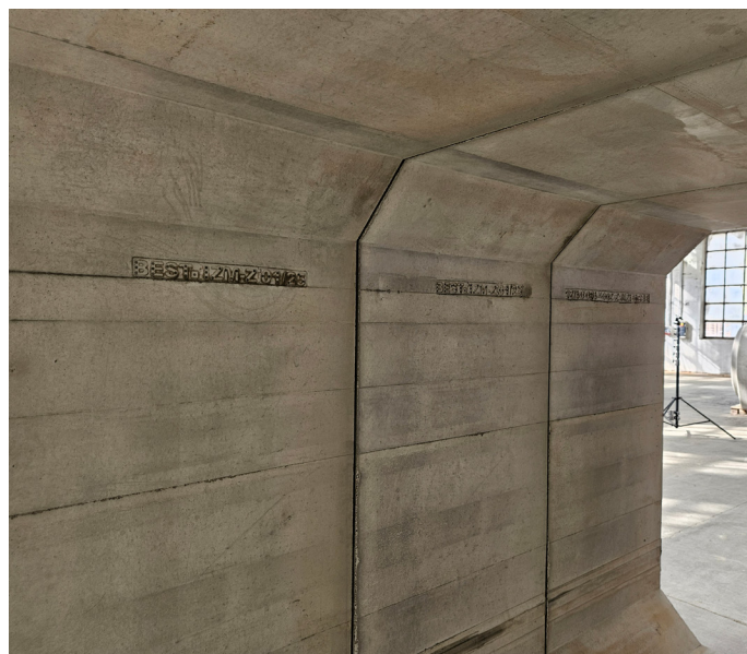
Maximální doporučená šířka vnitřní spáry rámových propustí pro garanci těsnosti spoje
