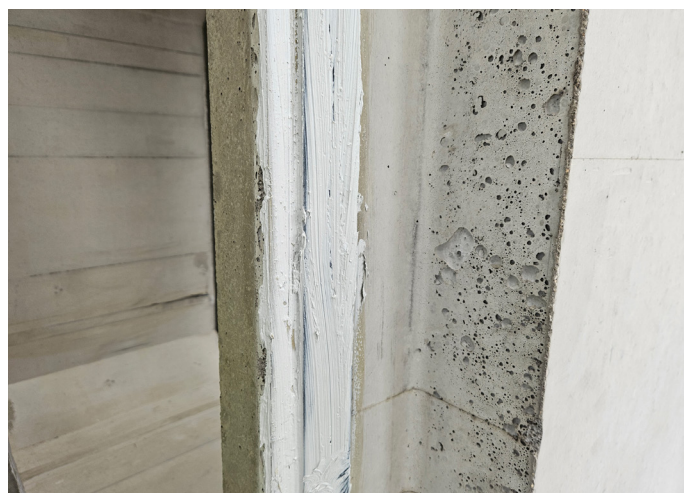
Obr. 5 Doporučená vnější spára rámových propustí před zahájením spojování řetězovým stahovákem
