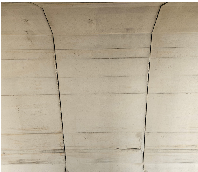
Finální vnitřní spára pro spojení rámových propustí
