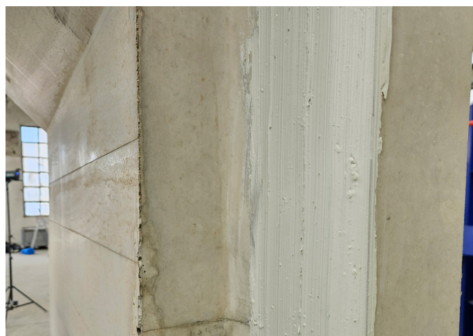
Obr. 4 Ukázka aplikace kluzného prostředku na dříku s těsněním rámové propusti
