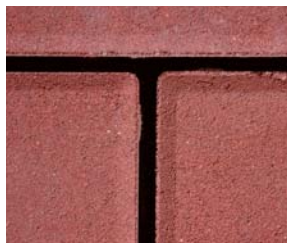
SPRÁVNĚ (PŘED ZAPÍSKOVÁNÍM) dodržena spára 3–5 mm
