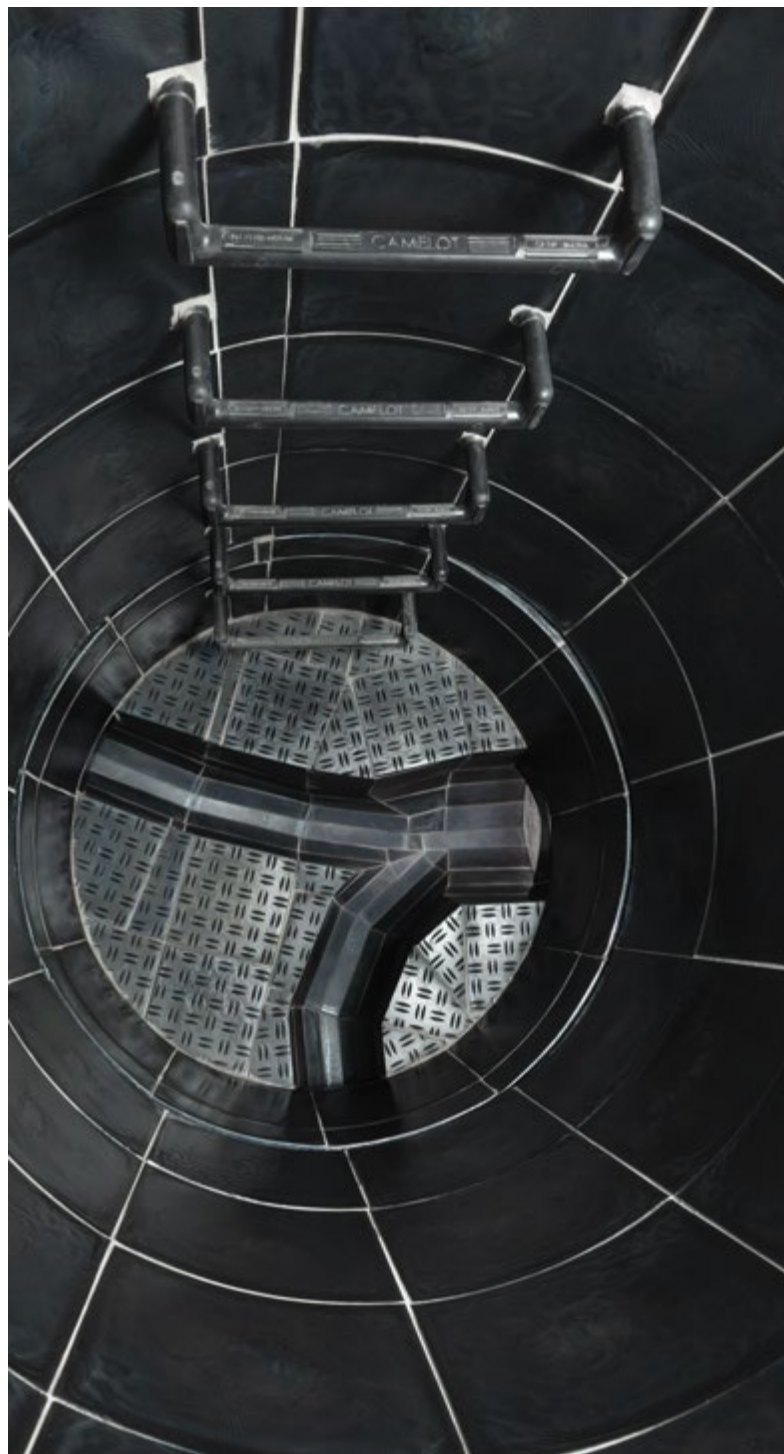
Vnitřní obklad spadišťové šachty čedičem
