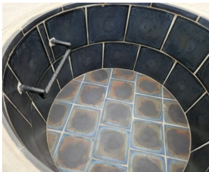
Šachtové dílce s čedičovým obkladem
