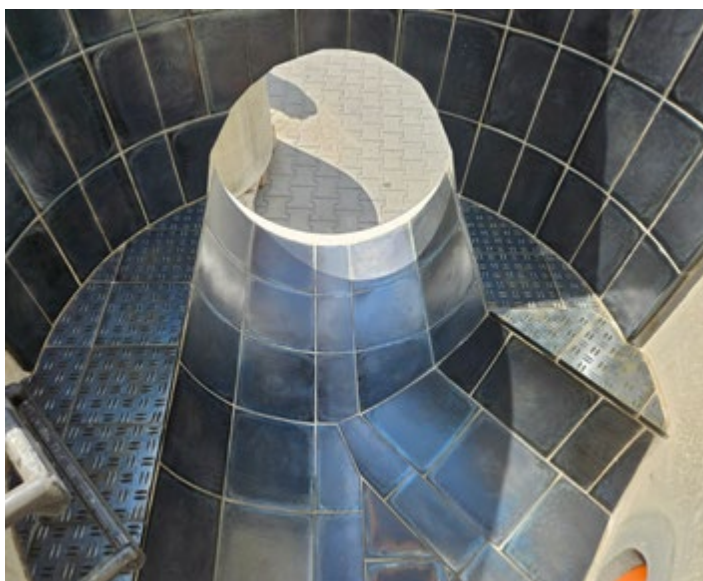
Šachtové dno s čedičovým obkladem
