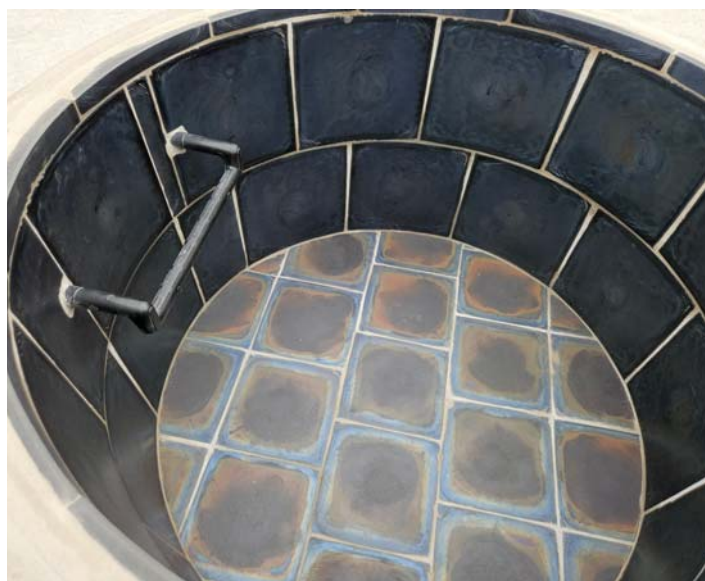
Šachtové dílce s čedičovým obkladem
