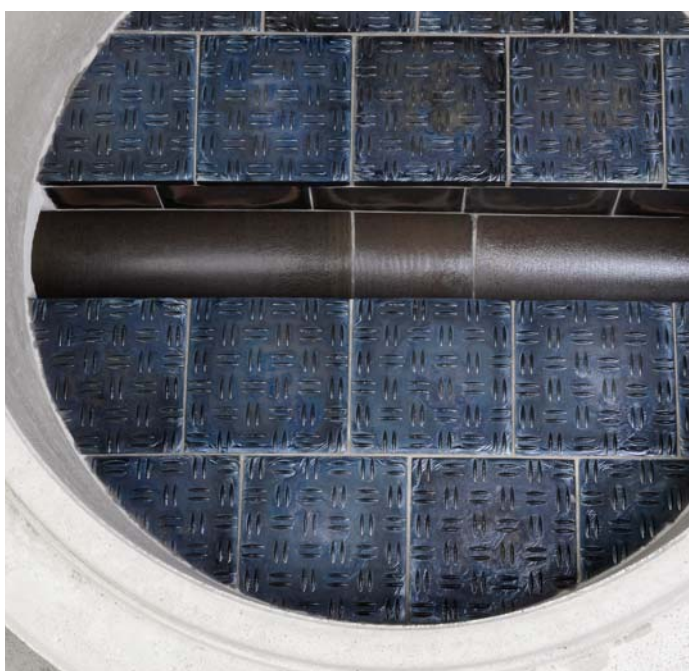
Čedičové dlaždice v protiskluzovém provedení
