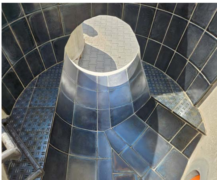
Šachtové dno s čedičovým obkladem
